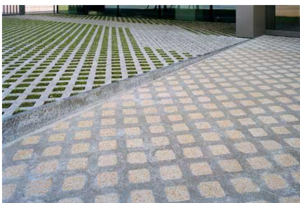
Figura 2 - Turfstones: bloco de concreto com cobertura impermeável de aproximadamente 60%, preenchida com solo e grama. Fonte: www.ecoengenharia.com.br
